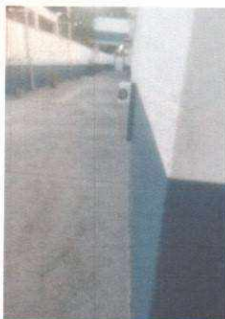
Conclusão da Pintura do quintal d abrigo.
