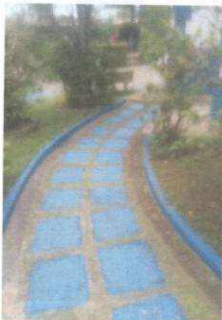
Pintura de toda área externa
