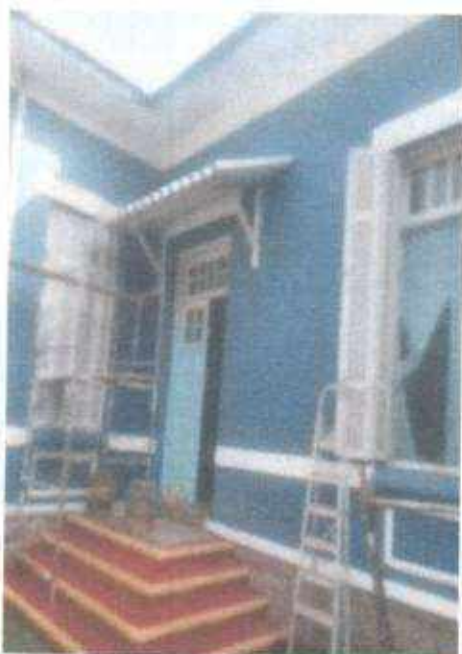
Pintura de Pátio Interno da Unidade I
