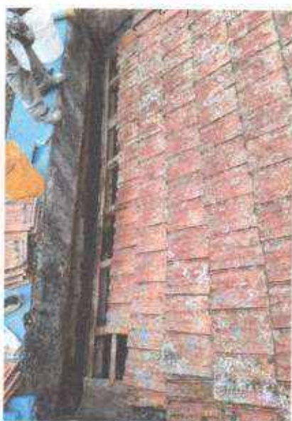
Reforma do telhado da Igreja
