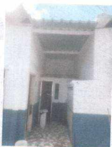
Telhado do Abrigo concluído
