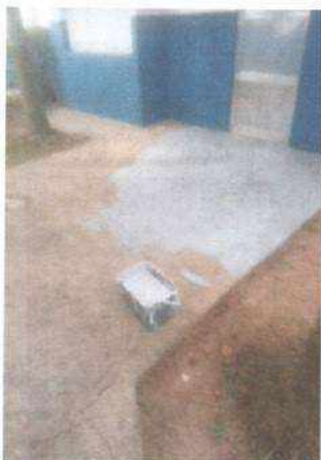
Pintura do Piso do quintal do Abrigo
