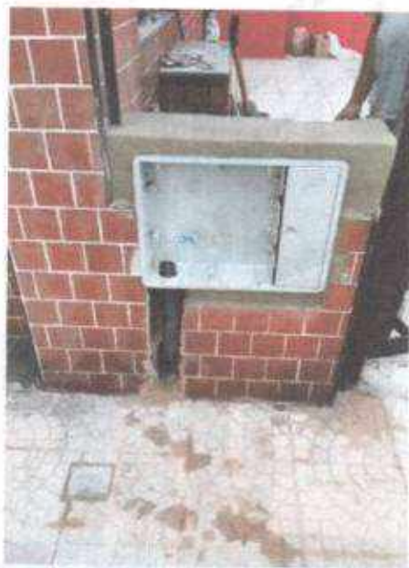
Colocação de Caixas para Instalação de Hidrômetro – Av. Conselheiro Nébias, 447
